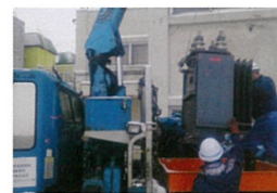
低濃度PCB作業風景
