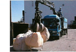
フレコンバックによる分別処理は、混合状態の処理とは異なり、リサイクル率の向上や処理コストの削減に繋がります。
